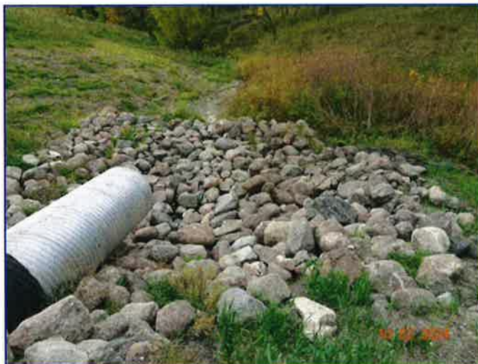
Photo 5 - Conduit outlet.
